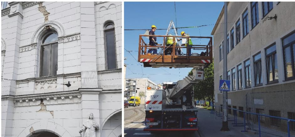
Slika 1. Prikaz rozete i prihvata kontaktne mreže na fasadi oštećene građevine - lijevo, ispitivanje nosivosti prihvata kontaktne mreže na fasadi građevine – lijevo
