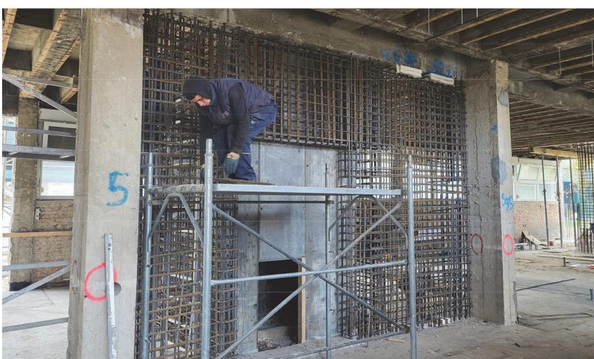
Slika 20. Izvođenje novih armiranobetonskih zidova unutar postojećeg objekta [8]
