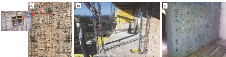
Slika 11. Primjeri iz prakse: a) torkret zidova, b) izvedba novih AB serklaža; c) izvedba FRCM sustava [8]
