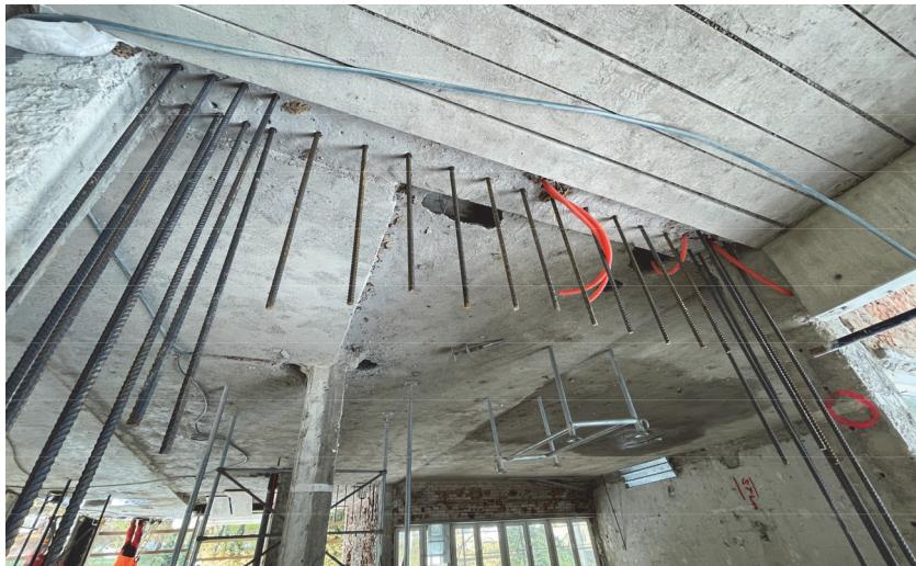
Slika 21. Povezivanje armature novih armiranobetonskih zidova kroz postojeće grede [8]
