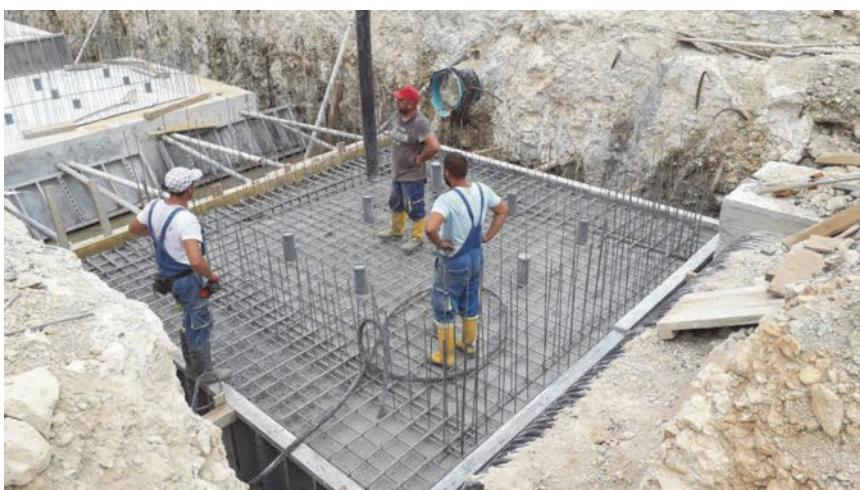
Slika 40. Betoniranje temeljnih ploča armiranih nehrđajućom armaturom na Gornjem mostu (arhiv Spegra Inženjerинг d.o.o.)
