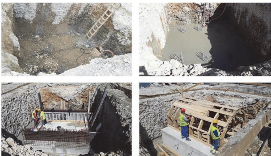
**Slika 17. Donji most, faze izrade armiranobetonske ploče dna ispod svodova (fotografirao Grget, G.)**
