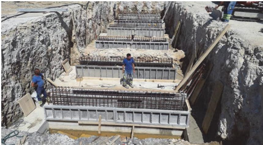
Slika 39. Izvedene ploče dna i priprema betoniranja naglavnih greda na Gornjem mostu (arhiv Spegra Inženjerинг d.o.o.)
