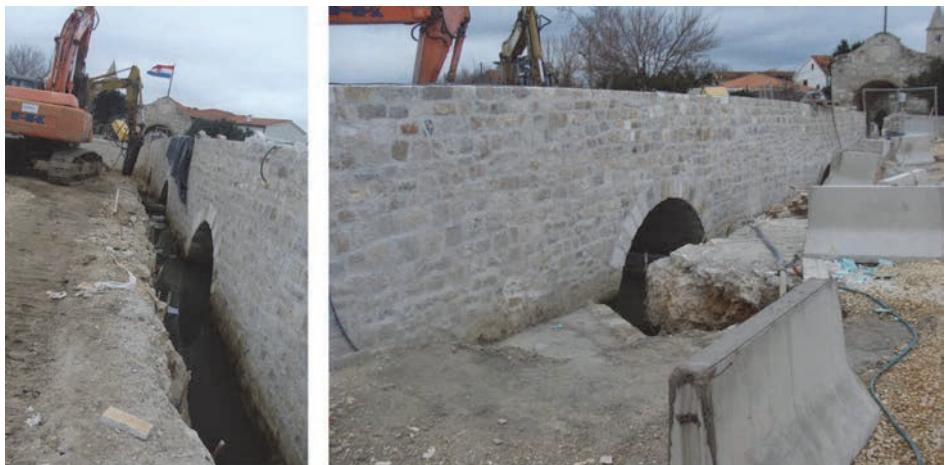
Slika 36. Donji most 31. siječnja 2020: lijevo - uklanjanje radnog nasipa uz sjeverozapadno pročelje, desno izgled dijela jugoistočnog pročelja (fotografirao Grandić, D.)
