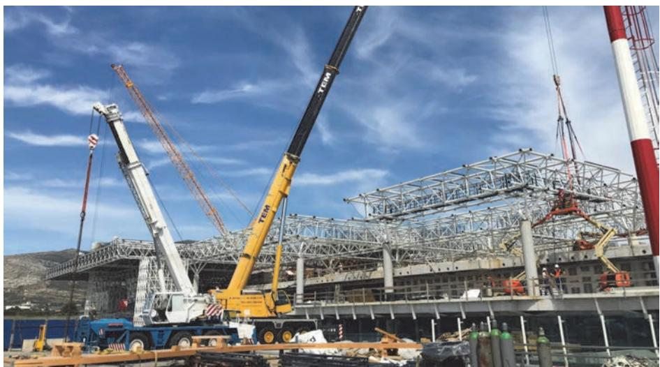
Slika 6. Montaža čelične krovne konstrukcije
