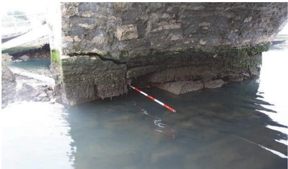
Slika 15. Donji most, oštećenje temelja svoda 1 [10]
