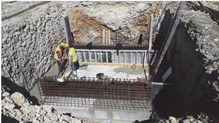
Slika 32. Izrada ploče dna i naglavnih greda pilota na Donjem mostu (arhiv Spegra Inženjering d.o.o.)
