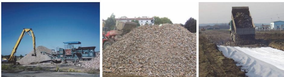
Slika 20. Mobilno postrojenje za recikliranje građevnog otpada (lijevo), reciklirani agregat (sredina) i primjena recikliranog agregata (desno)
