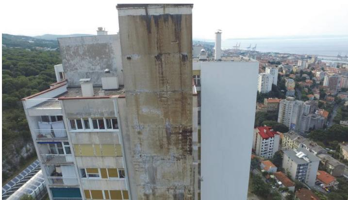
Slika 3. Pregled stometarskog dimnjaka bespilotnom letjelicom
